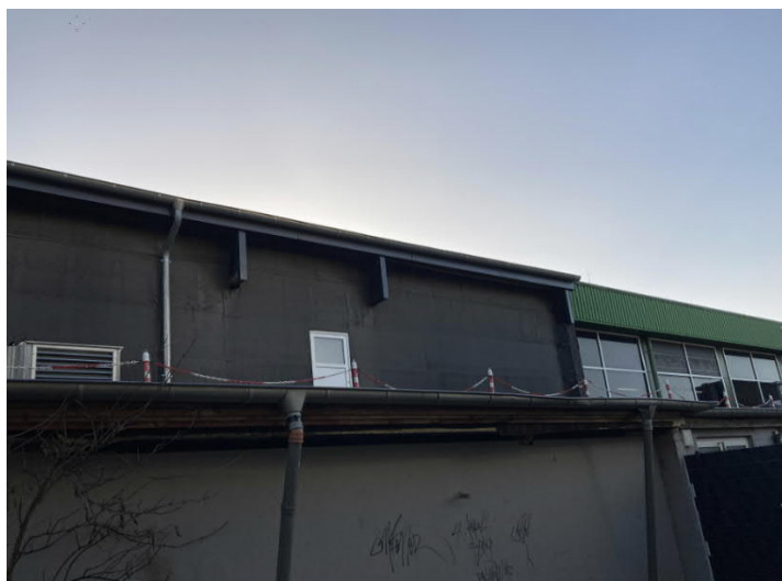
Abgedichtete Außenwand aus Holz und Bitumen
