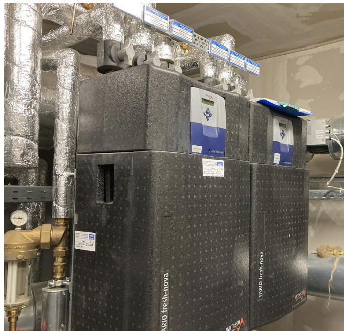
Warmwasser- Wärmetauscher
