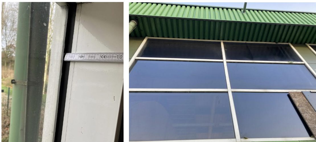
Fenster in der Eishalle
