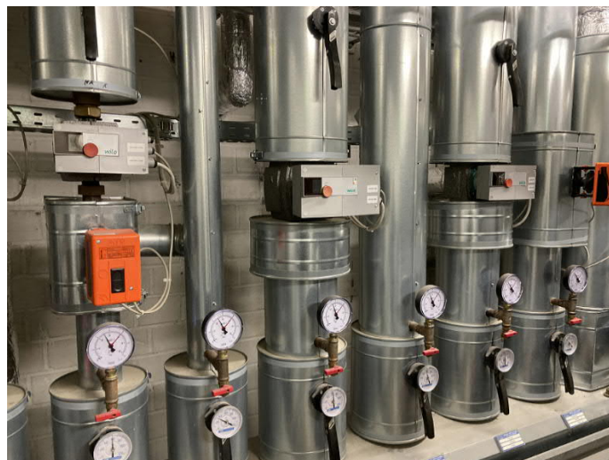
Heizkreisverteiler
