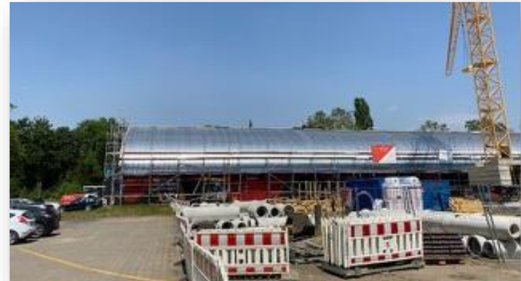
Zustand während der Sanierung
