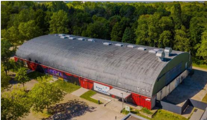
Zustand vor der Sanierung
