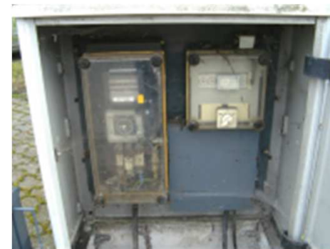
Defekte Verteilerkästen
