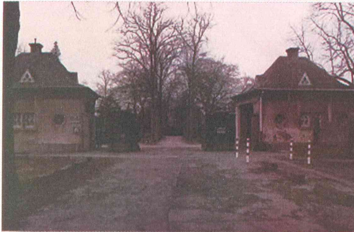
Bild 6: Foto der beiden Torhäuser, Friedhof Repelen
