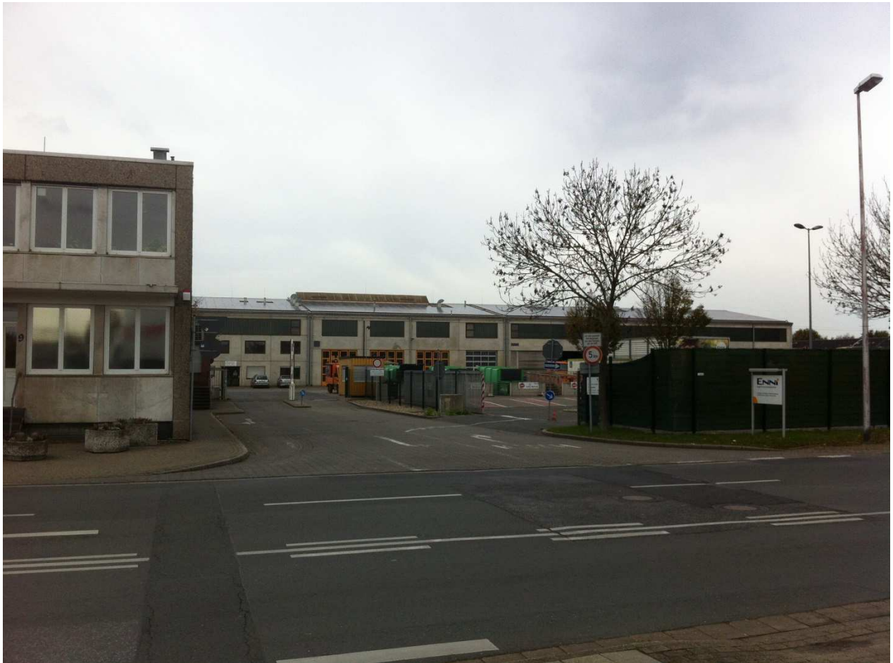
Zufahrt Werksgelände Enni Stadt & Service Sowie Zufahrt Kreislaufwirtschaftshof
