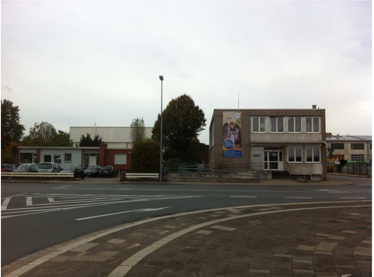
vorh. Verwaltungsgebäude Am Jostenhof 7-9
